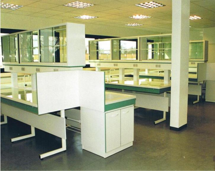
Paillasse centrale composée d'un plan de travail de 1200, 1500 ou 1800 mm de profondeur surmonté d'une poutrelle (ou fontaine) et d'un meuble surélevé composé de deux faces avec portes coulissantes vitrées.
